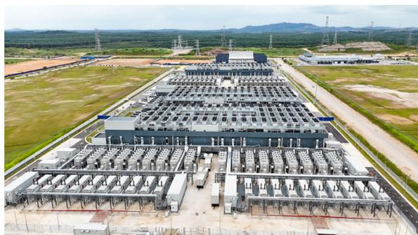
智算时代加速到来，亚太成为全球智算中心建设高地，位于马来西亚柔佛州的数据中心标杆项目采用华为电力模块FusionPower9000，通过架构全解耦，实现一箱一路电、一体化快速部署，上线时间缩短50%至10个月，打造了全球智算数据中心标杆。
