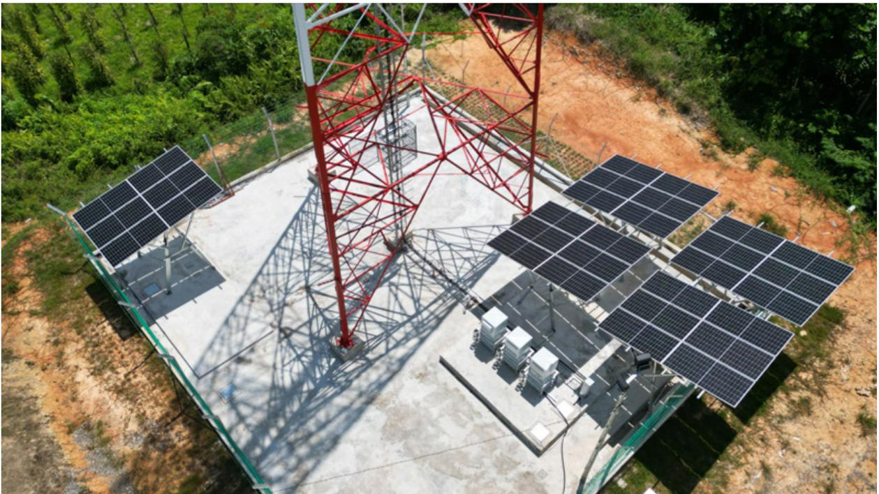
在马来西亚，华为站点能源助力客户在偏远山区建设太阳能站点，其中光照条件优越的站点，可实现100%太阳能供电和零碳排放，站点能源费用平均减少了90%以上，电源可用性由低于85%提高至99.5%以上。运维人员通过智能管理平台NetEco进行站点远程运维，过去每月两次人工下站变为日常无需人工下站，项目运营体验焕然一新。
