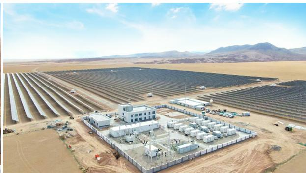
左图：在中东红海之滨，华为通过400兆瓦光伏和1.3吉瓦时储能，采用大规模构网技术，助力客户打造了全球最大的光储微网电站，实现城市100%可再生能源供电。截至2024年底已连续稳定运行16个月，提供了超过10亿度绿电。
