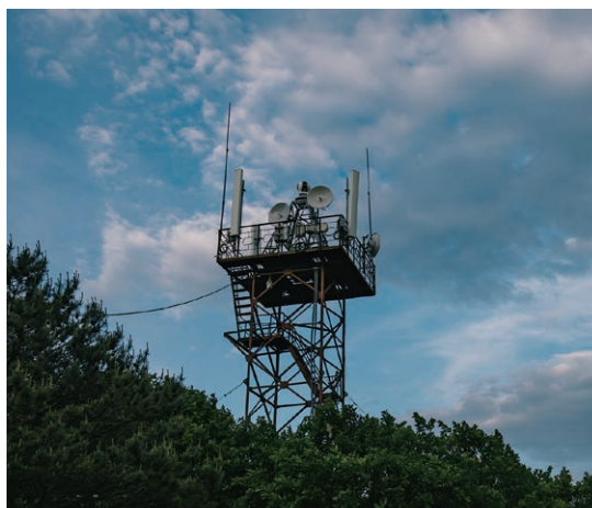
东北虎豹国家公园的LTE基站，利用原有的防火塔，最大限度减少对自然的影响
