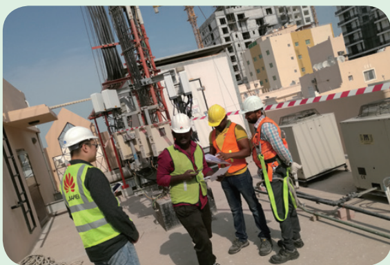
交付站点EHS现场检查
